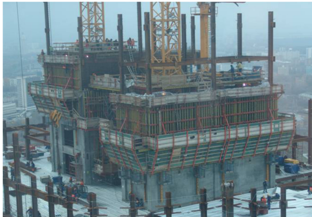
Рис. 3. Самоподъемная опалубка (строительство в г. Москве в 2008 г.)
