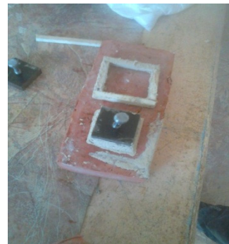
Рис. 1. Устройство штукатурного слоя на поверхности кирпича с помощью опалубки
